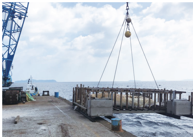
写真4. ミンククジラの海中沈下処理（山口県長門市：Y22-003）。5m四方の鉄枠を作成、中に鯨体を入れて海中に沈められた。
