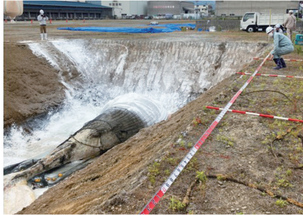
写真2. ザトウクジラの埋設処理（淡路市：Y25-003）。穴の深さは約3 m、消毒用生石灰が散布された。
